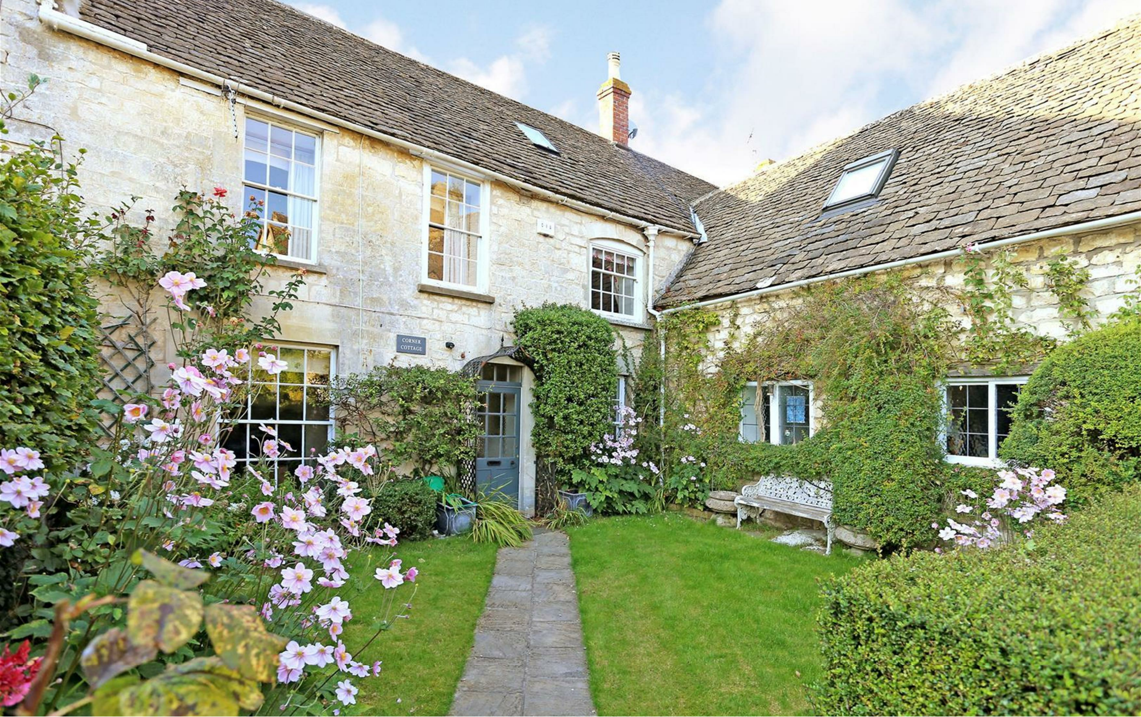
Corner Cottage · Barn Close · · Nailsworth
